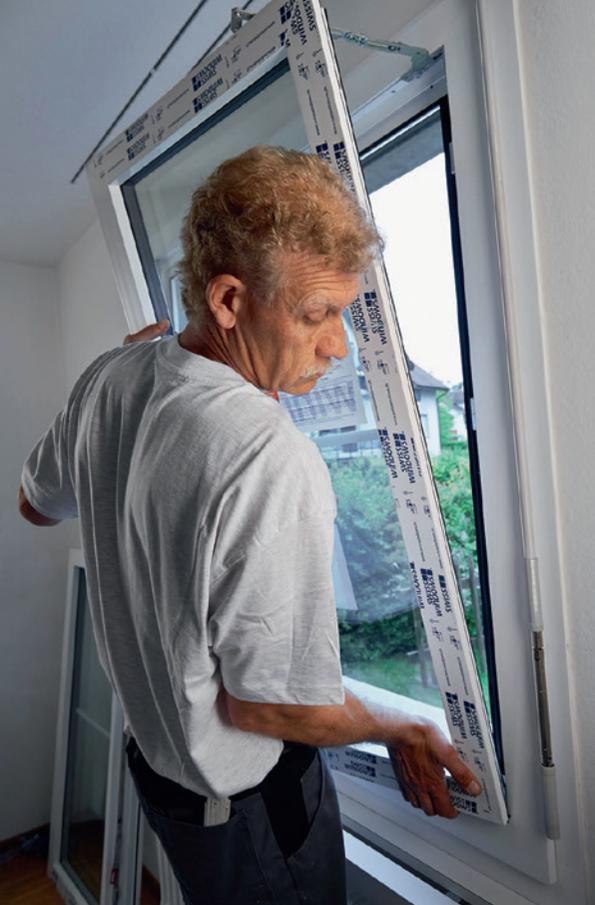
Fenstersystems sind bestehend. Hochwertige Dreifachverglasung sorgt für maximale Wärmedämmung, für optimalen Schallschutz und hohe Einbruchsicherheit. Der Bauabschluss ist sauber abgedichtet, das hochwertige Material auf Langlebigkeit ausgerichtet. imago erreicht einen Dämmwert von 0,6 W/m<sup>2</sup>K. Damit ist selbst der hohe Minergie P Standard keine Herausforderung.
