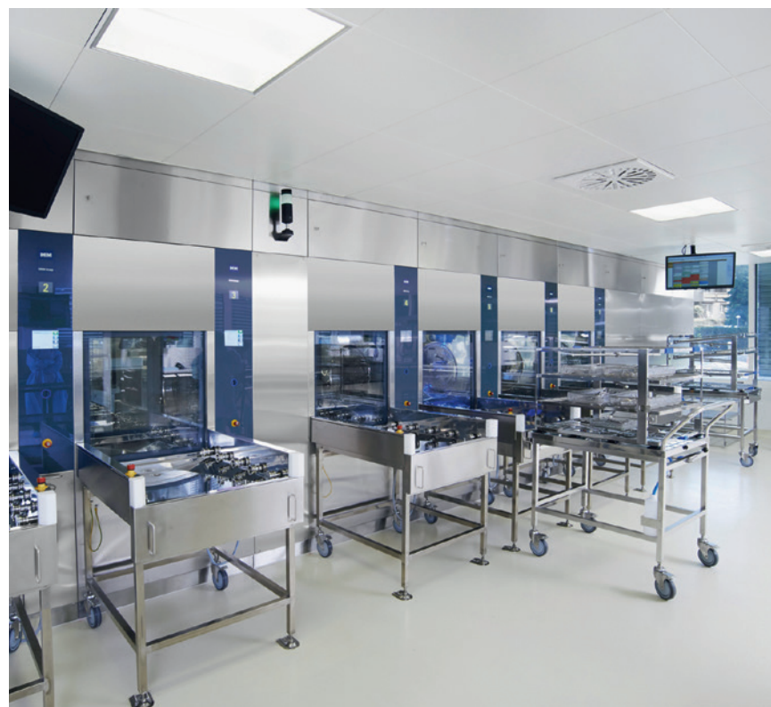
Technologie der neuesten Generation von der Firma MMM Sterilisatoren AG: Dampfsterilisatoren Selectomat PL (links) und Reinigungs- und Desinfektionsanlagen Uniclean PL II (rechts)
