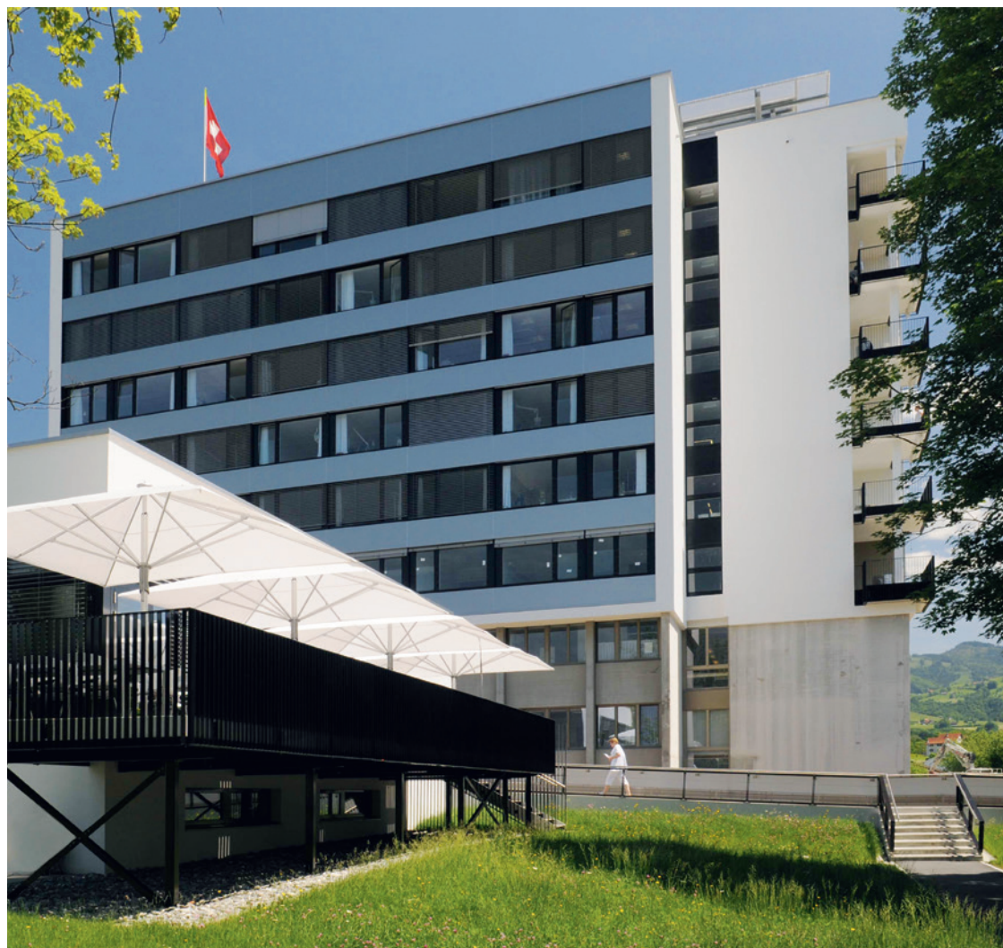
Spital Linth Uznach, 2001–2009 Erneuerung und Gesamtanierung unter laufendem Betrieb
