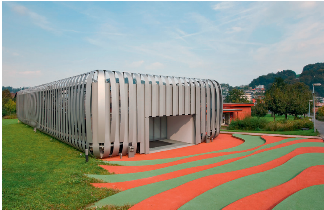
Das iHomeLab – Hochschule Luzern: Hinter der intelligenten Fassade, die sich den jeweiligen klimatischen Situationen anpassen kann, verbirgt sich eine Denkfabrik und Forschungslabor für Gebäudeintelligenz.
