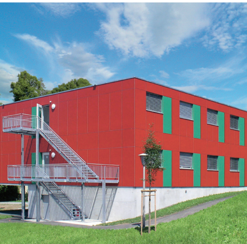
Zweigeschossiger Spitalbau in «medico» Modulbau-System
