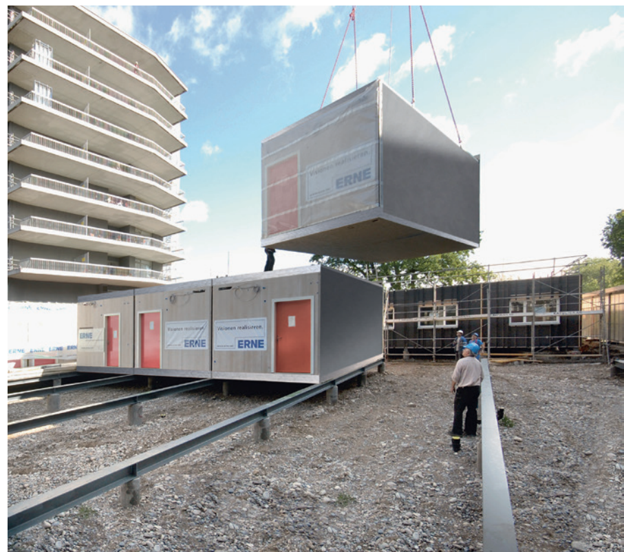
Vorgefertigte «medico» Raum-Module werden just-in-time auf die Baustelle geliefert
