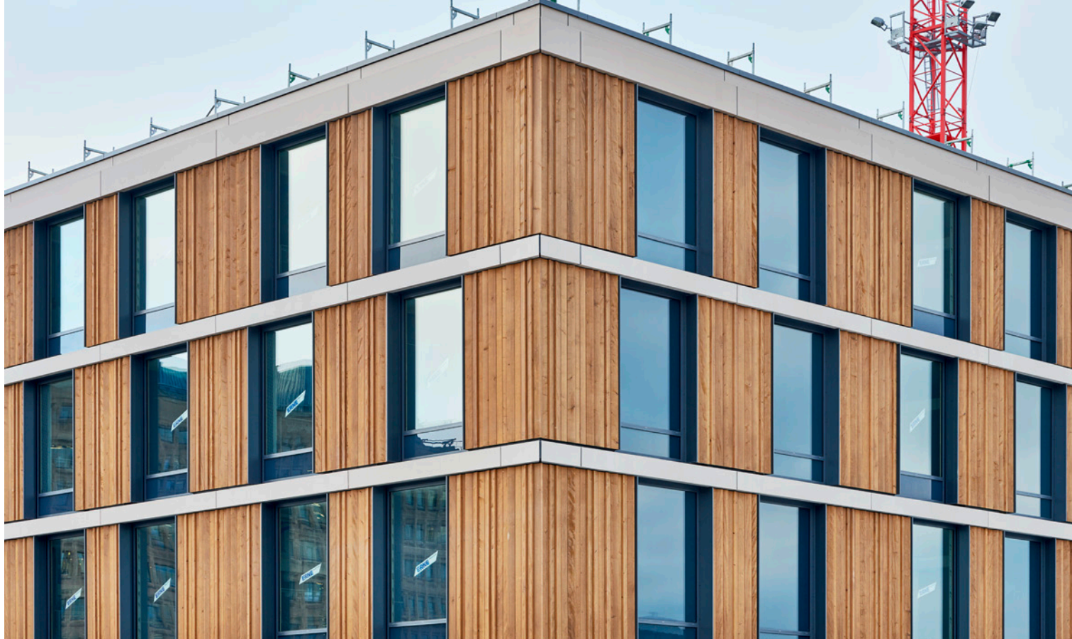
La façade créative en bois local souligne l'architecture de l'hôpital cantonal de Baden.
