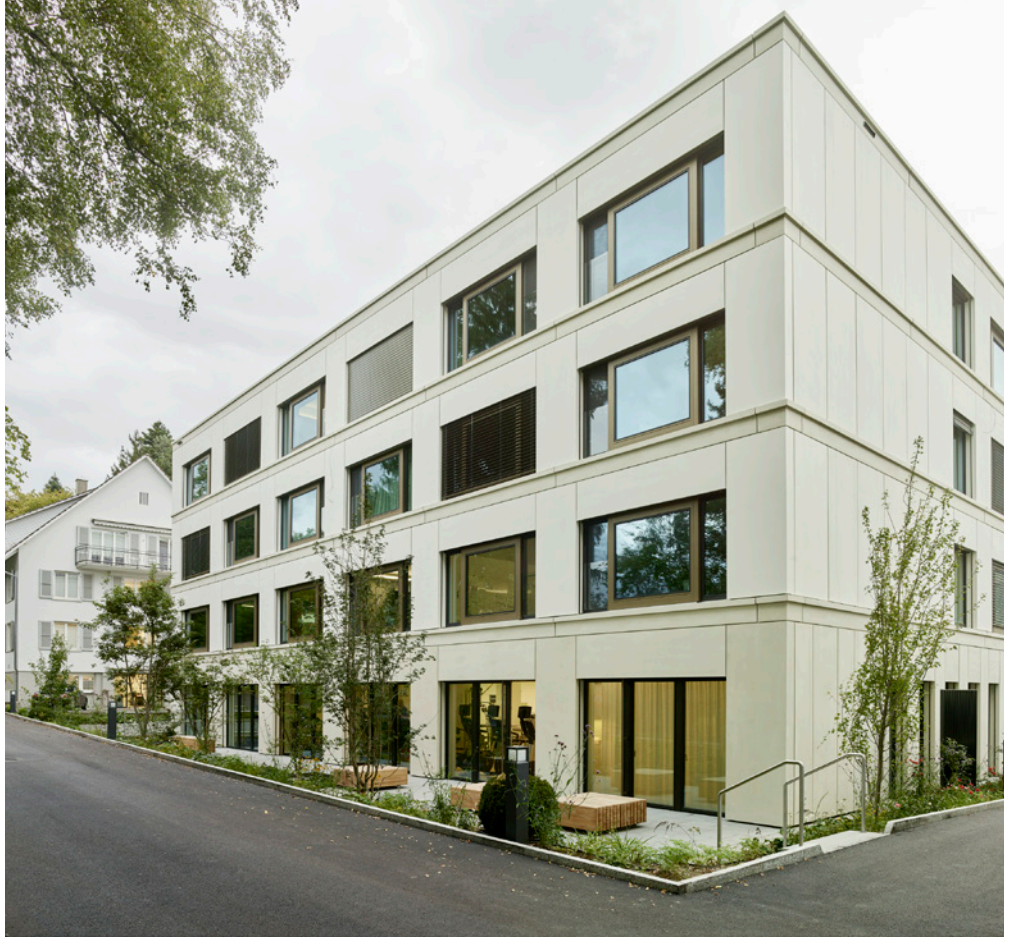
La clinique privée Linde à Bienne possède une façade en éléments préfabriqués en bois et revêtus de béton fibré et des fenêtres à menuiserie métal / bois de chêne.
