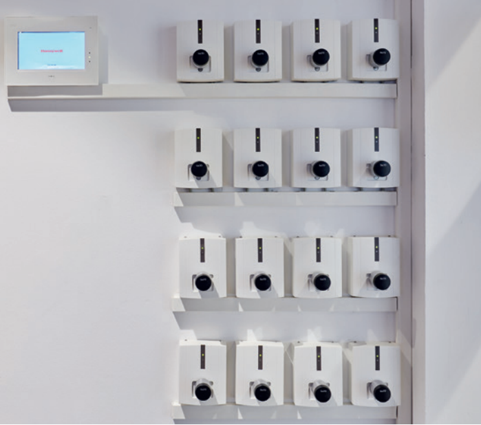
Cylindre électronique en remplacement de la mécanique : Ici dans les interrupteurs à clé d'un système d'alarme anti-intrusion.
