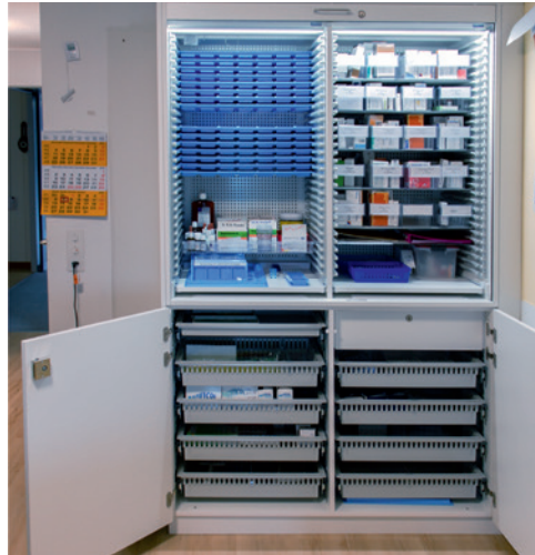
In diesem klimatisierter Medikamentenlagerschrank wird die Medikation für eine Woche gelagert sowie alle Bedarfs- und Reservemedikamente.
