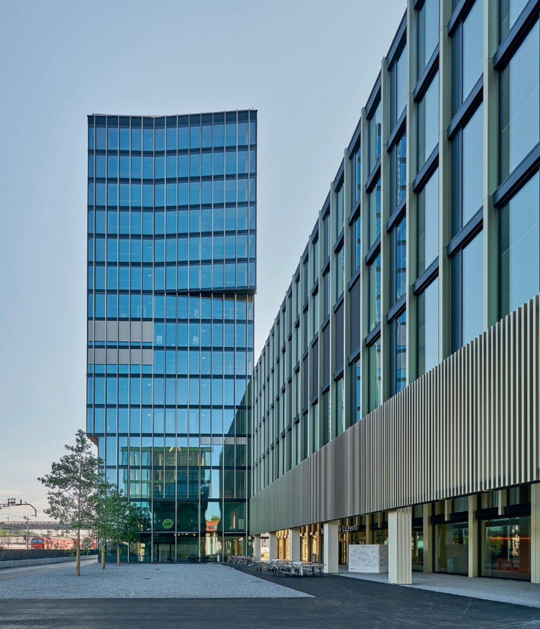
Ein zweites charakteristisches Beispiel für das 3 R-Konzept ist das ARBO-Gebäude, Risch-Rotkreuz. In diesem höchsten Holz-Hybrid-Hochhaus der Schweiz belegt z.B. die Hochschule Luzern neun Etagen.
