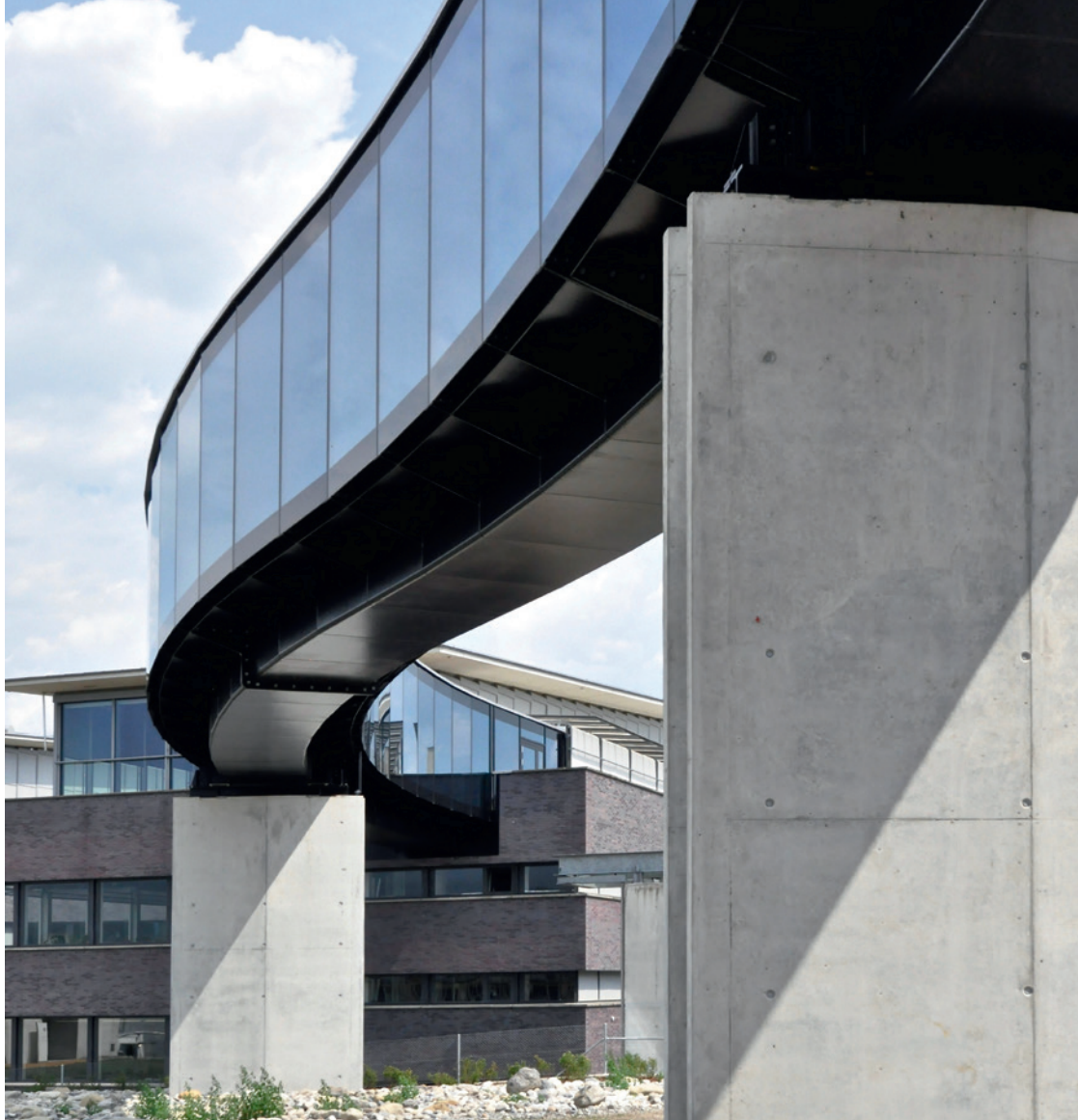
Passarelle zwischen Hotel und Guido-Zäch-Institut für eine rollstuhlgerechte Verbindung
