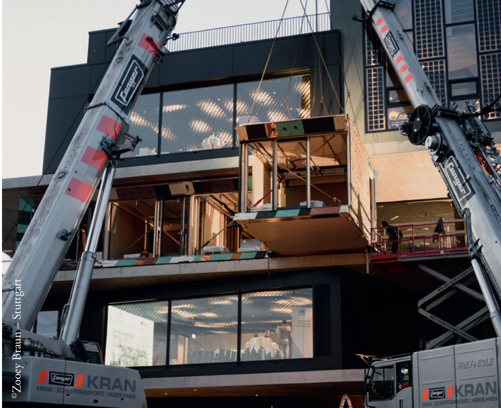
Abbildung 4: Einbau eines Moduls während laufendem Betrieb im Gebäude NEST der EMPA
