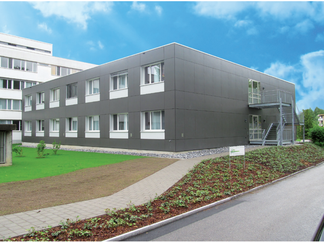
Speziell im Gesundheitswesen verfügt die DM Bau AG über eine grosse Erfahrung. Unser Bild zeigt den Bettentrakt beim Spital Lachen, der 2012 realisiert und zwecks grösserer Auslastung 2017 aufgestockt wurde.
