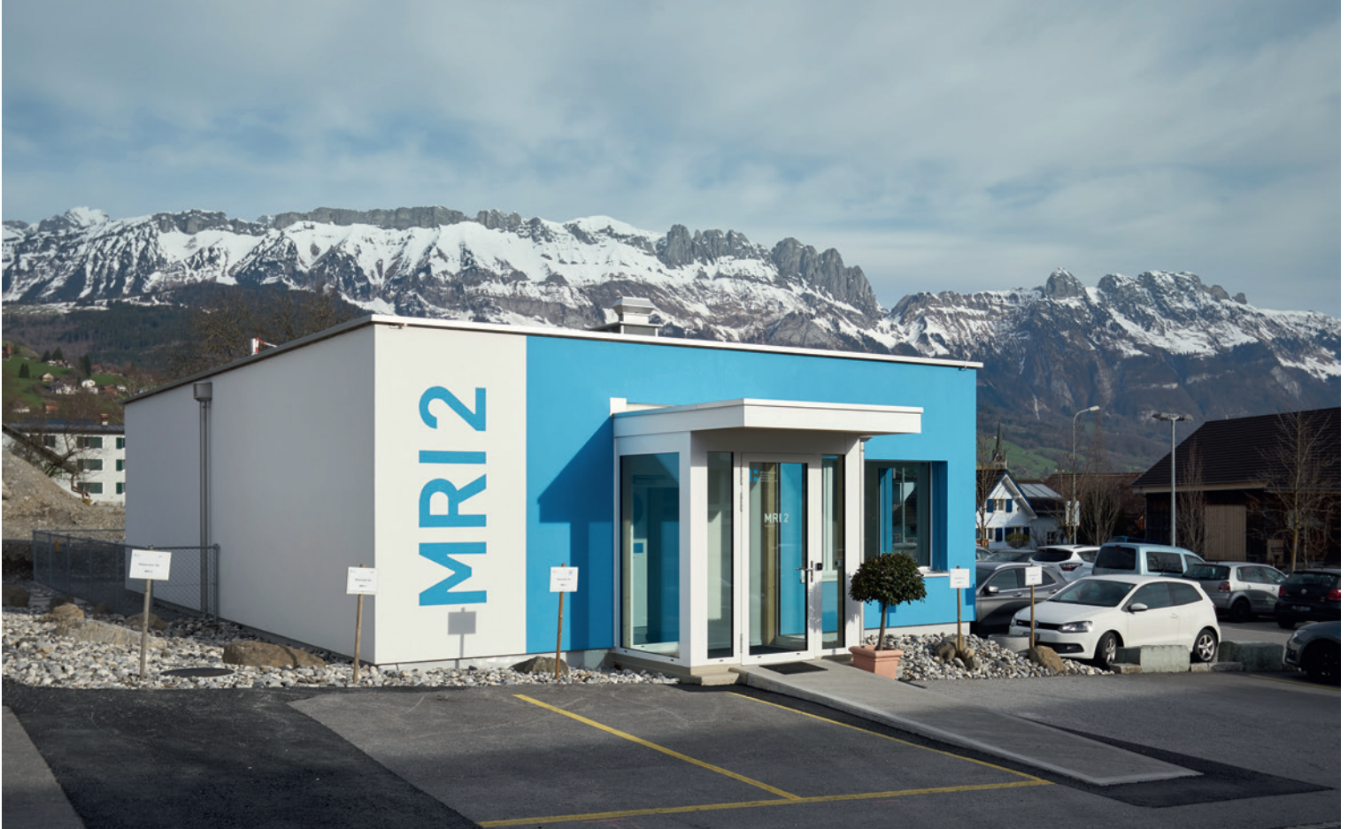
Das Spital Grabs (Spitalregion Rheintal Werdenberg Sarganserland) nutzt einen massgeschneiderten massiven Modulbau.
