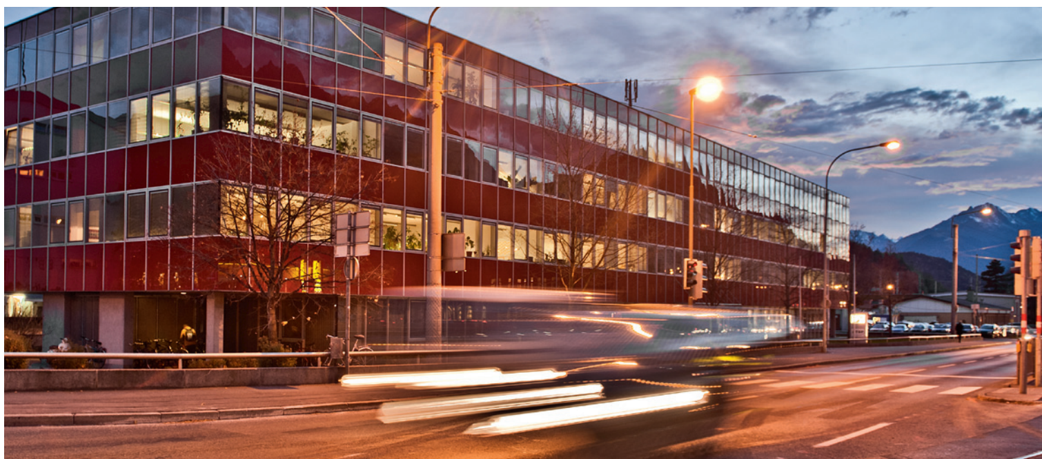
Firmengebäude ATSP / ARZ in Innsbruck: Hier arbeitet ein kompetentes Team an IT-Lösungen fürs Gesundheitswesen.
