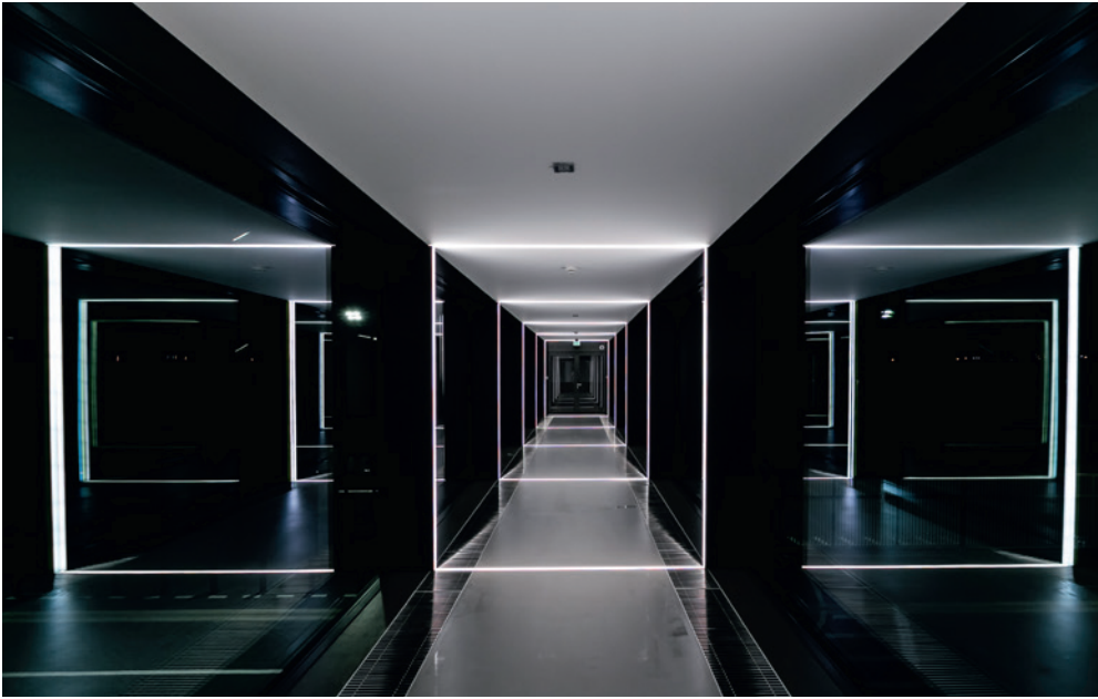
Der Datacenter-Bereich eilt von Rekord zu Rekord.
