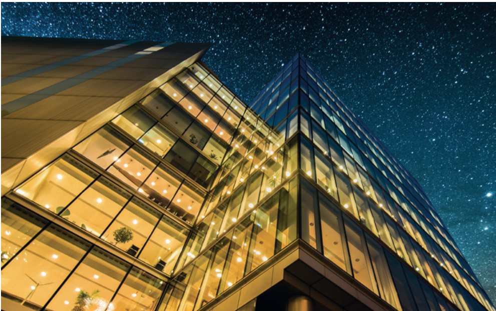
LED-Beleuchtungen über Power over Ethernet sind ein Trend im LAN-Bereich.
