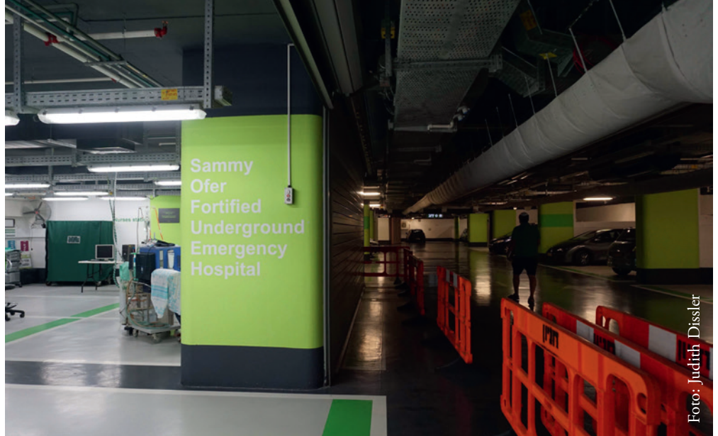
Abbildung 6: Die drei Ebenen des Untergrund-Parkings lassen sich in 72 Stunden in ein 2000-Betten-Spital umfunktionieren. Rambam Hospital, Haifa
