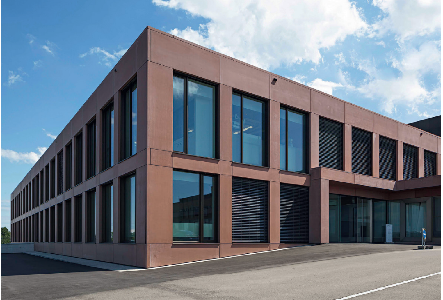
Neubau Osttrakt Kantonsspital Münsterlingen mit diversen Ambulatorien, Operationssälen und der zentralen Sterilgut-Versorgungsanlage.
