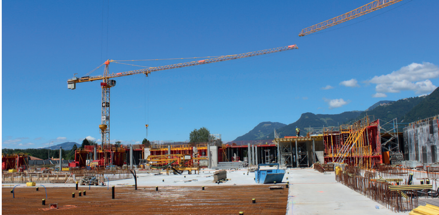
Ein Überblick über die Grossbaustelle: Die Bauarbeiten kommen dank exakter gemeinsamer Planung und Projektleitung von Spital und Steiner zügig voran.
