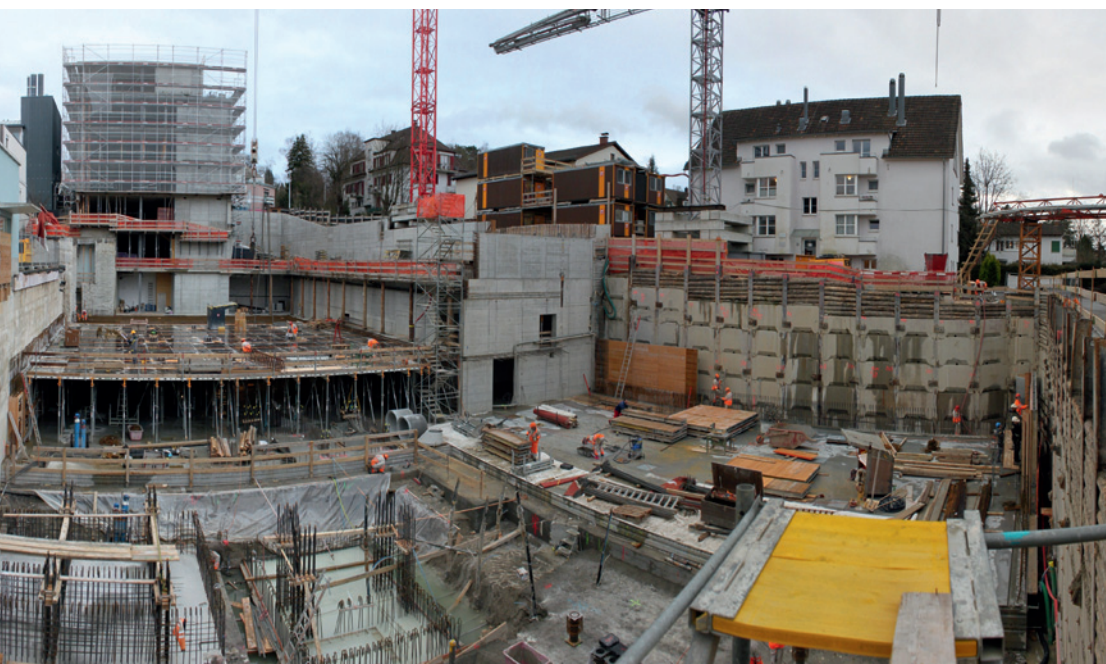
Klinik Hirslanden, Zürich: Baugrube mit dem ersten Teil des Enzenbühl-Trakts im Hintergrund.
