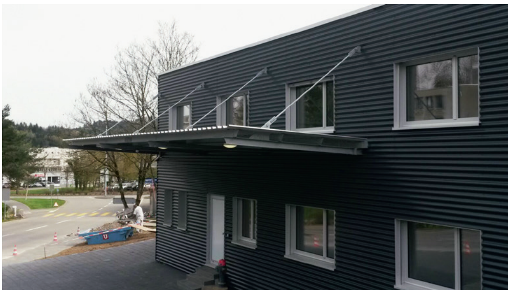
Exakt innert kurzer Zeit realisiert: Dank sorgfältiger Planung war der Modulbau nach nur 5 ½ Monaten bezugsbereit.
